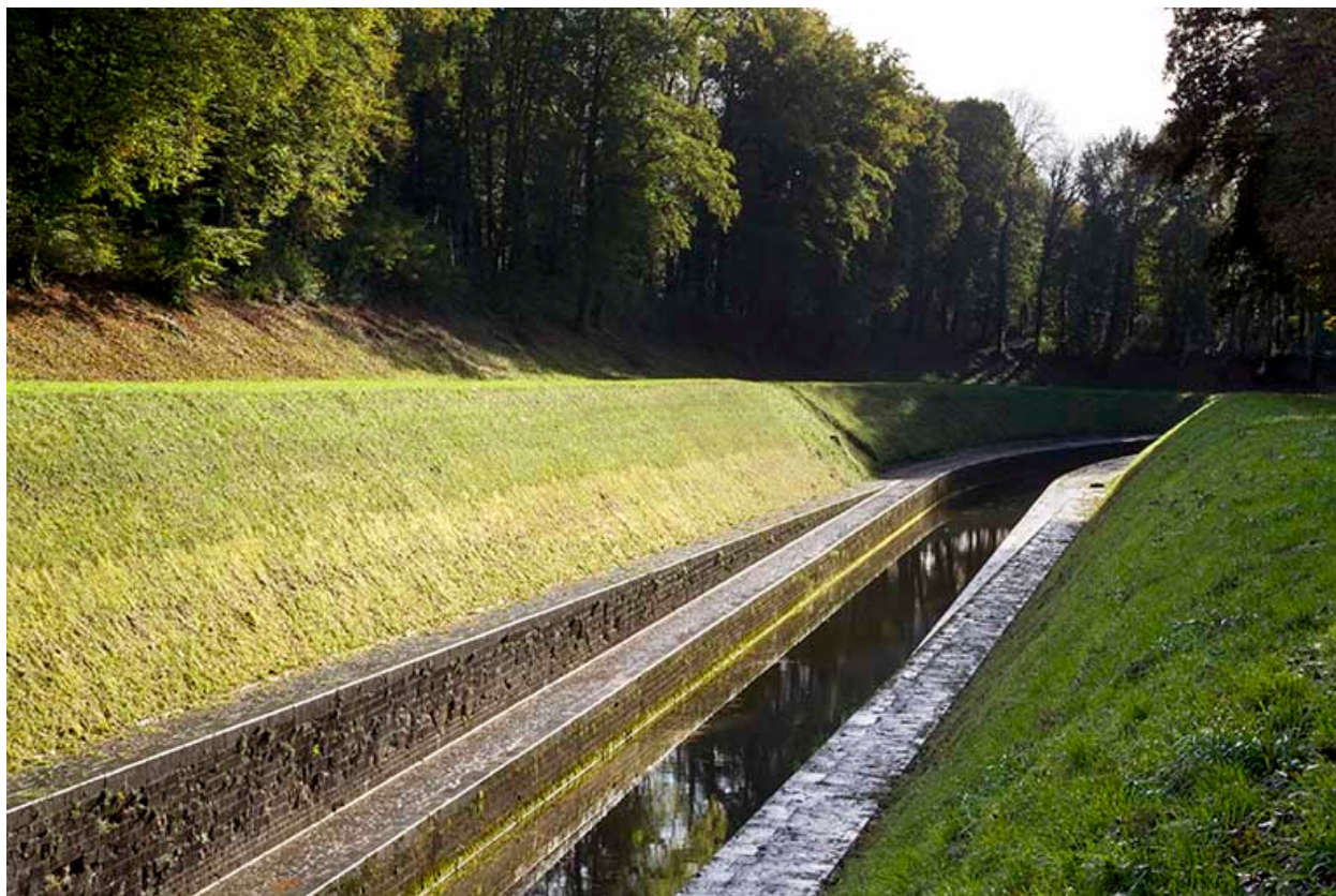
Le canal, vue aval.
