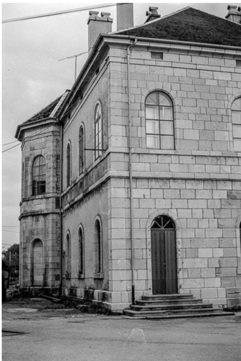
Façade postérieure en 1975.
