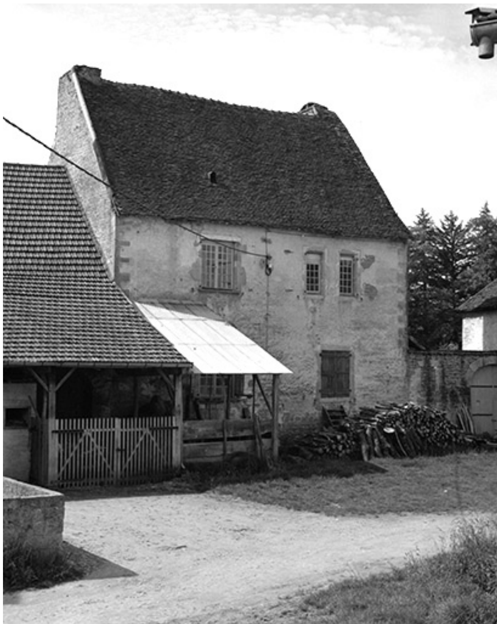
Maison cadastrée 1960 AI 76 : façade sur cour.
