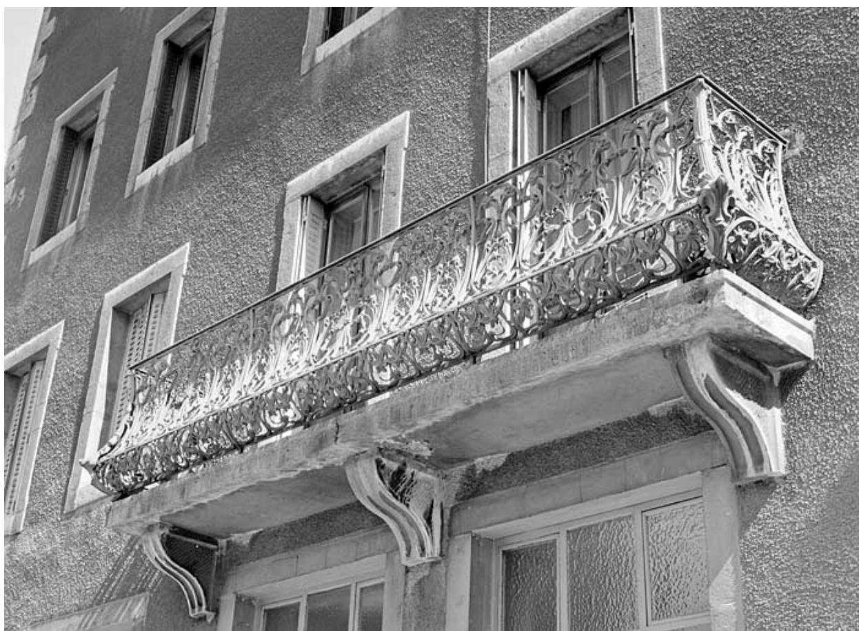
Balcon de l'immeuble.
