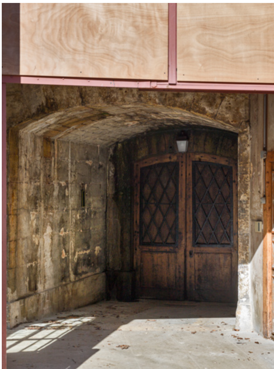
Entrée de la tour au rez-de-chaussée.
