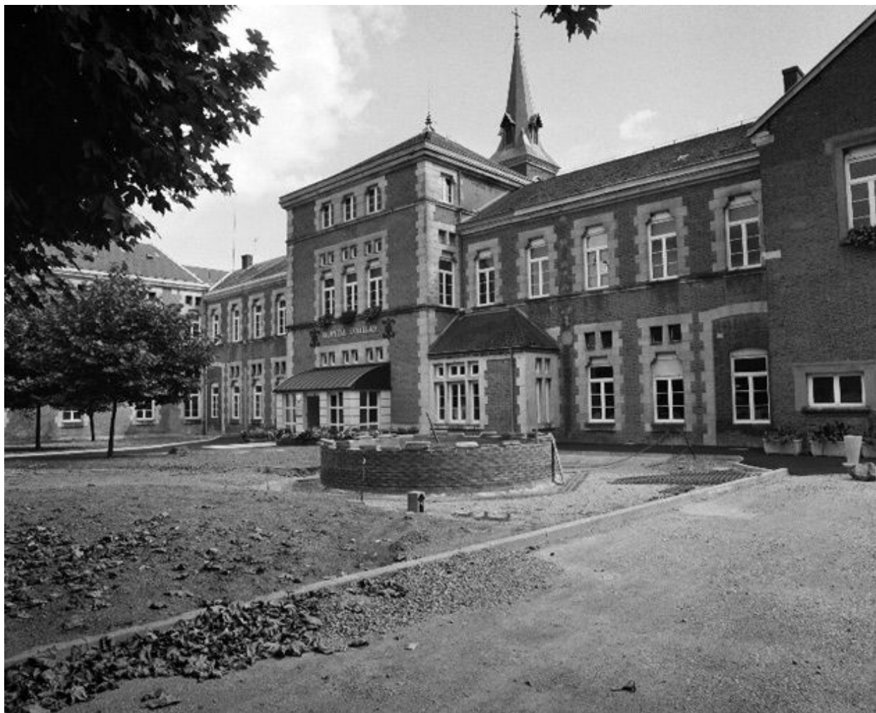
Façade postérieure de l'aile droite.
