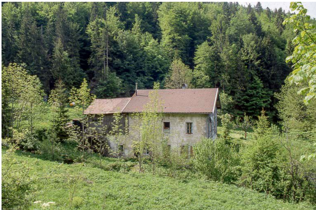
Façade postérieure, vue éloignée.
