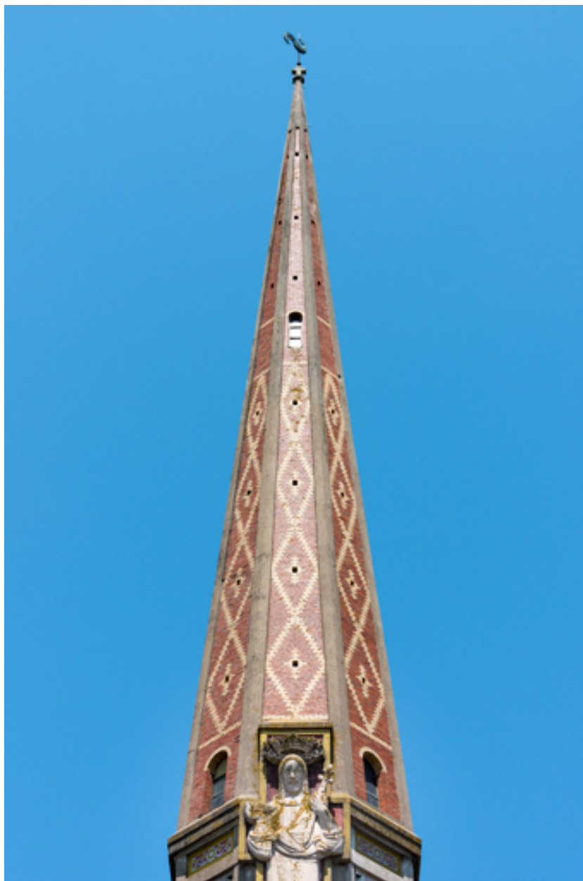
Toiture du clocher. Vue d'ensemble.
