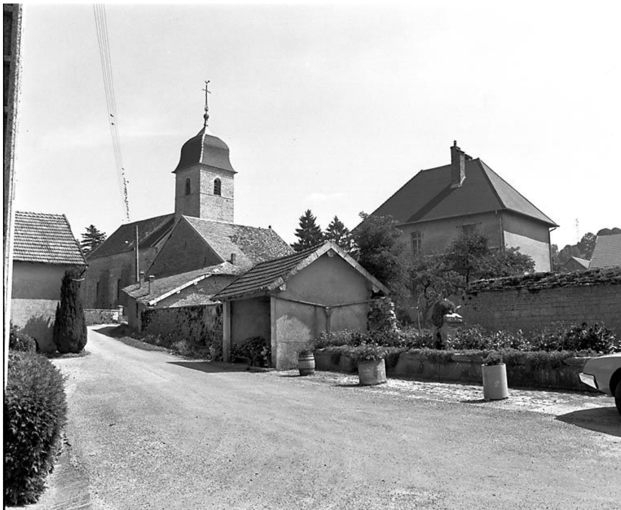
Fontaine-lavoir située rue de l'Eglise.
