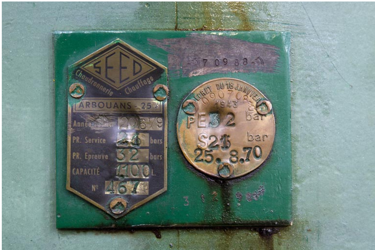
Réservoir d'air comprimé. Plaque d'épreuve.
