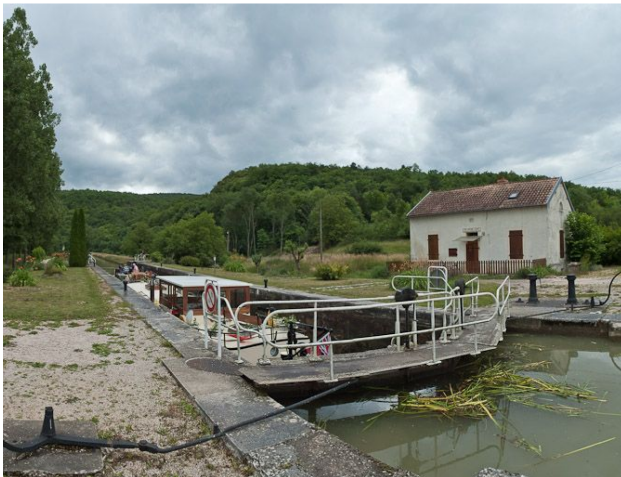
Vue d'ensemble du site d'écluse.
