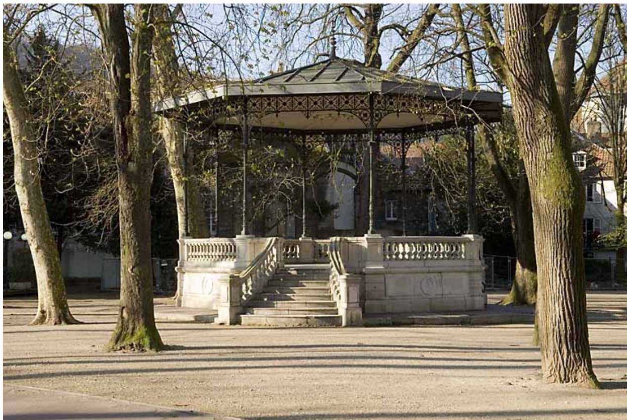
Kiosque : vue d'ensemble, de face.
