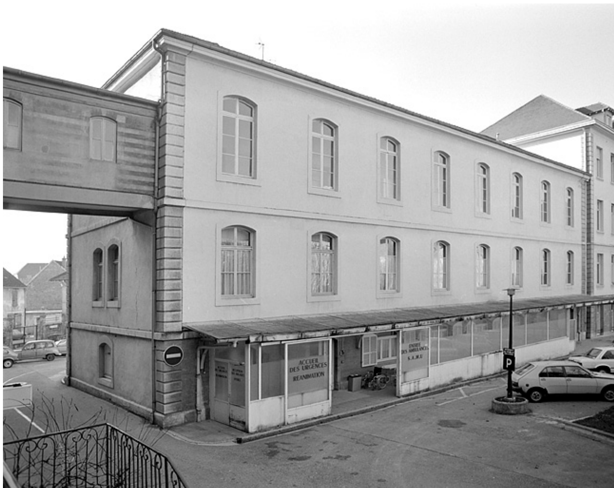
Bâtiment annexe (Pavillon sud) depuis la cour.
