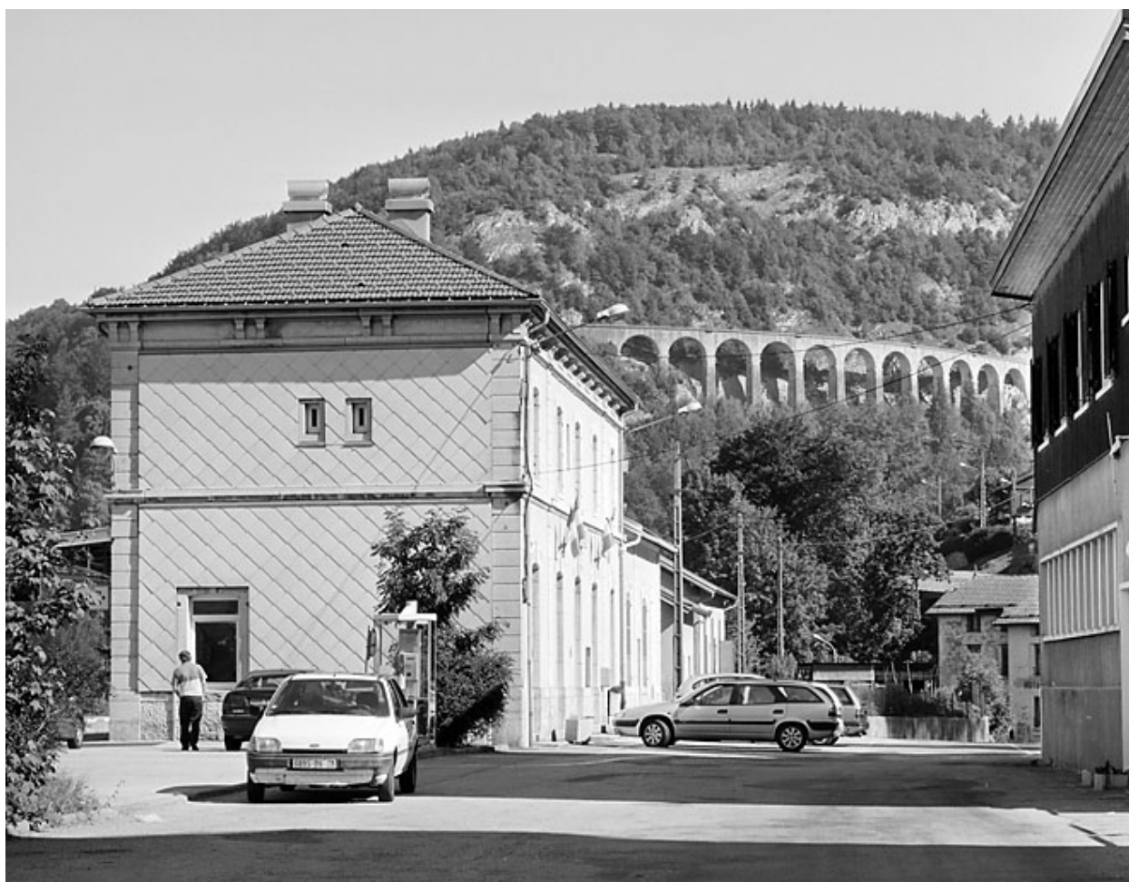
Bâtiment des voyageurs : façade latérale gauche.
