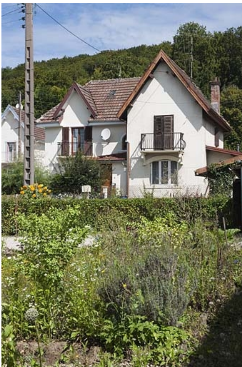
Maison de contremaîtres (n°4-6).
