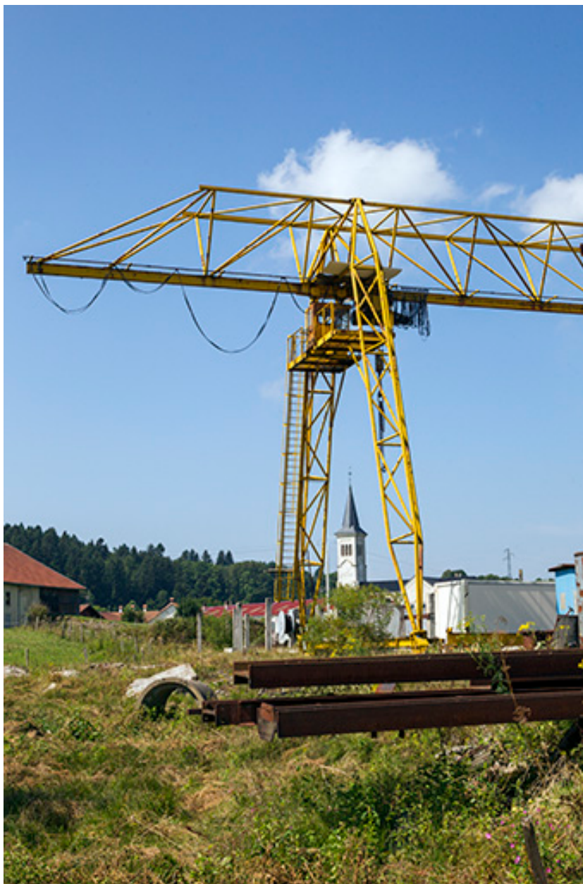
Portique roulant (extrémité sud).
