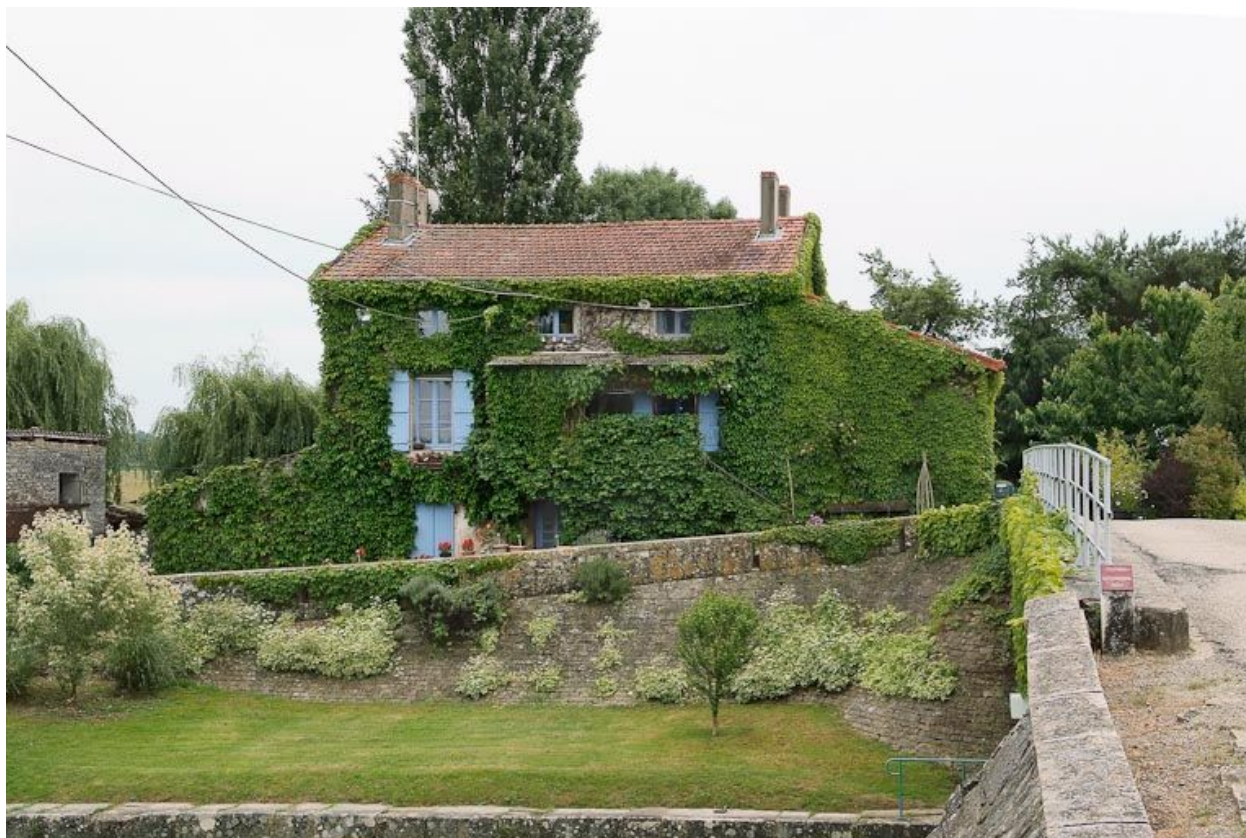
Le site d'écluse de La Truchère : le sas. A l'arrière-plan, la maison éclusière.
