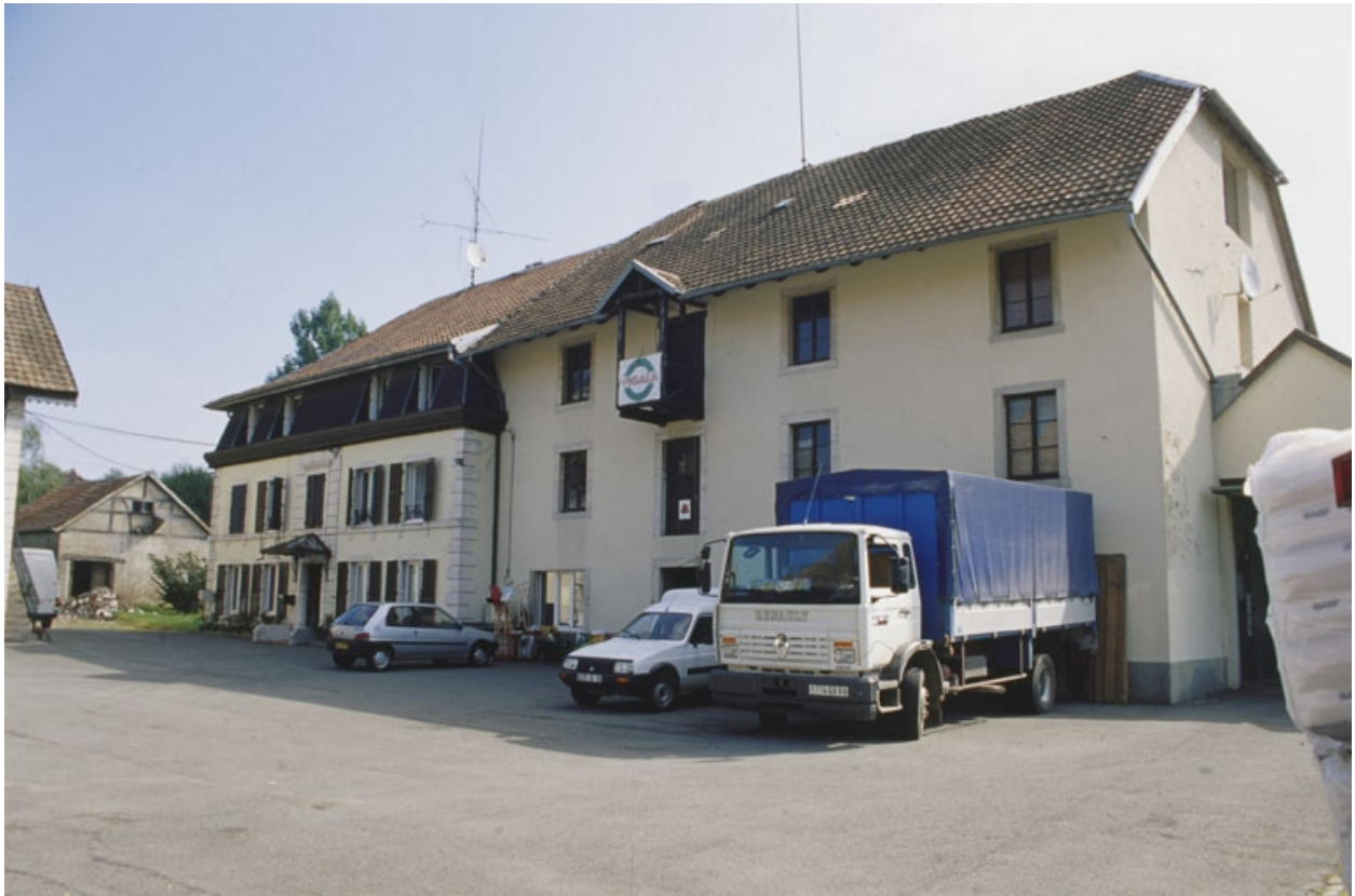
Logement et atelier de fabrication vus de trois quarts.
