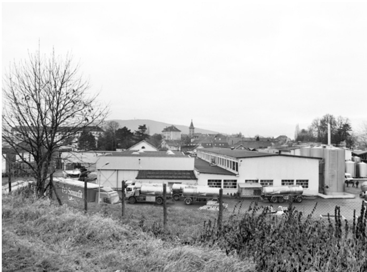
Vue plongeante sur les ateliers depuis l'est.
