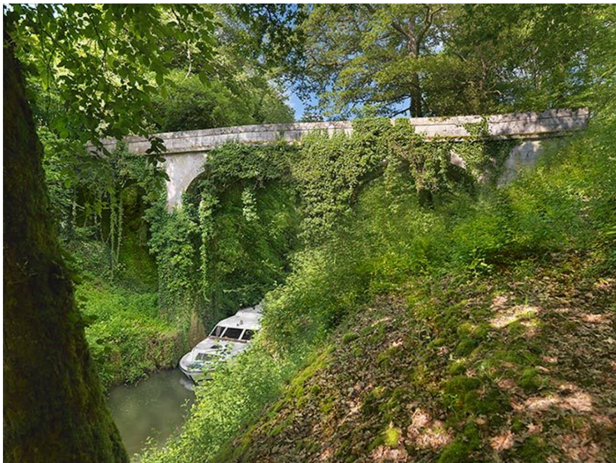
Vue d'ensemble du pont.
