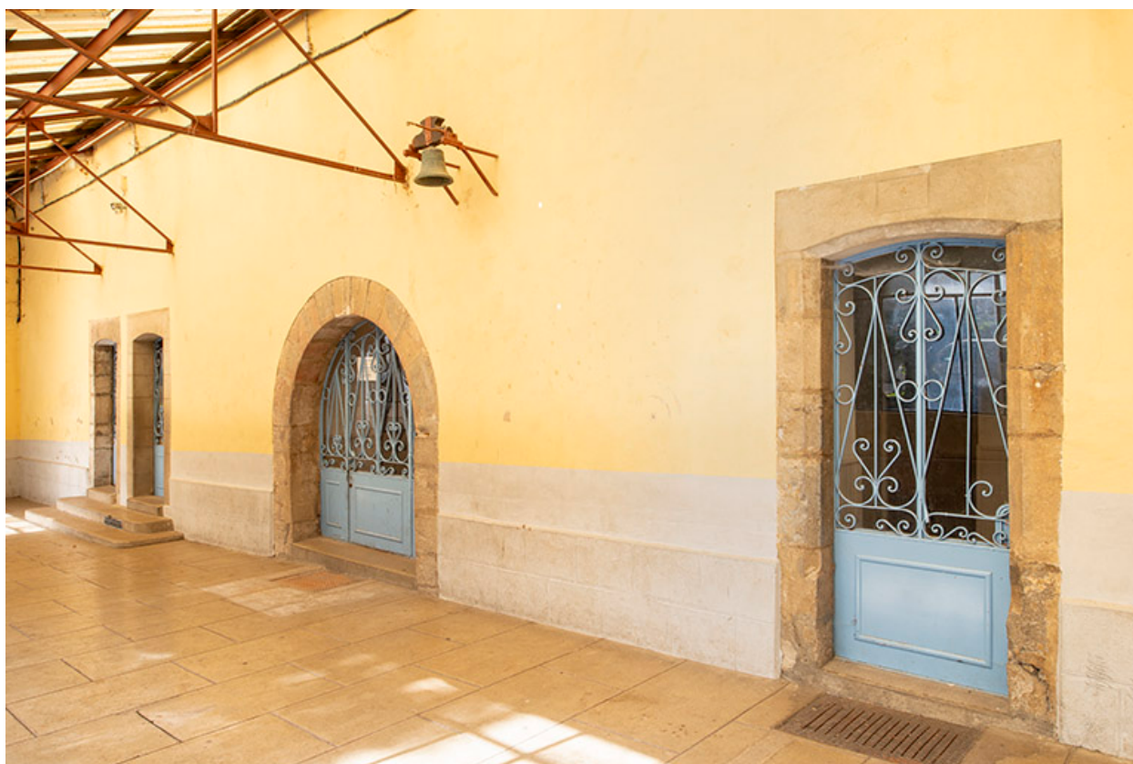
Bâtiment conventuel. Ouvertures de la façade est.
