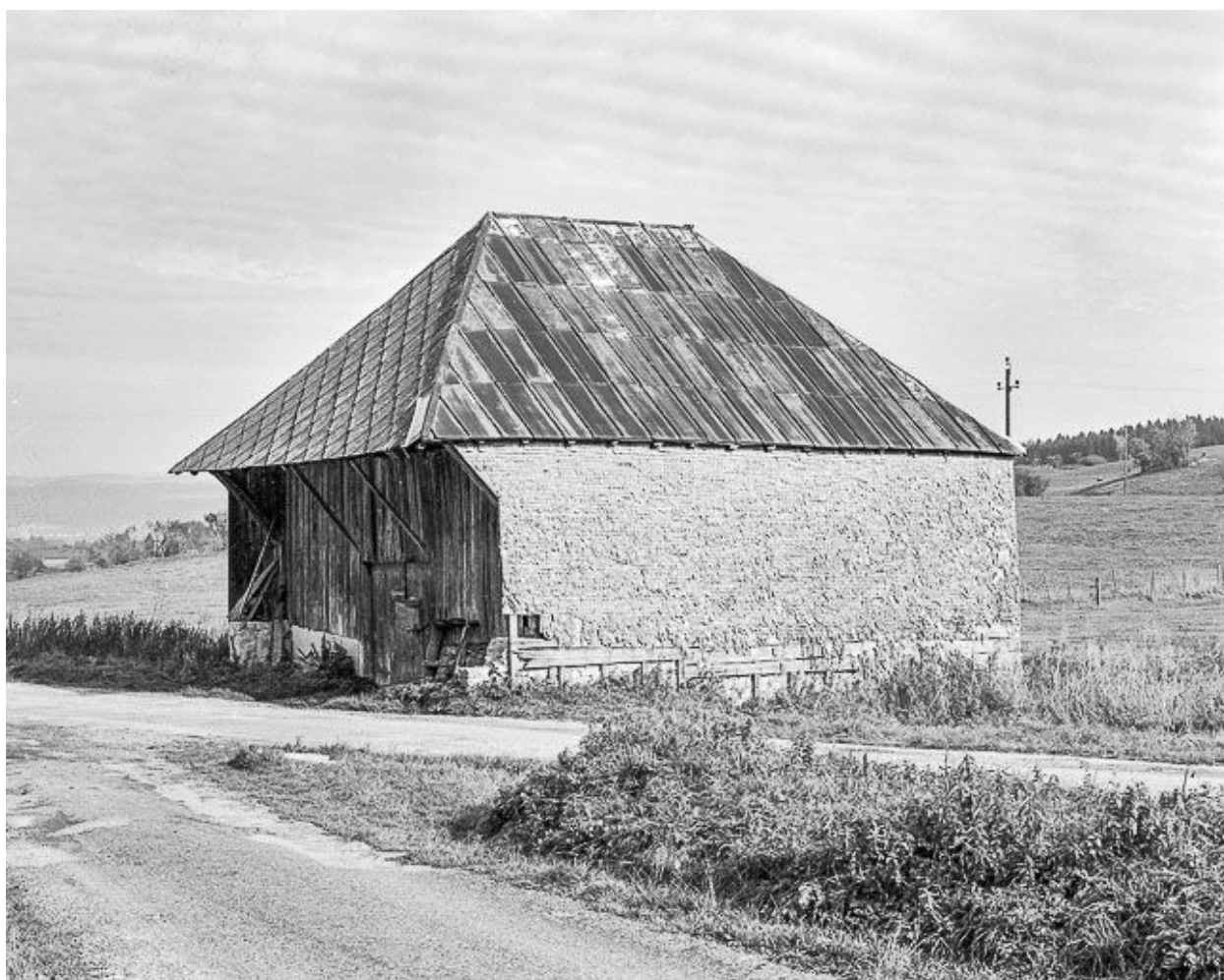
Bâtiment servant de remise.
