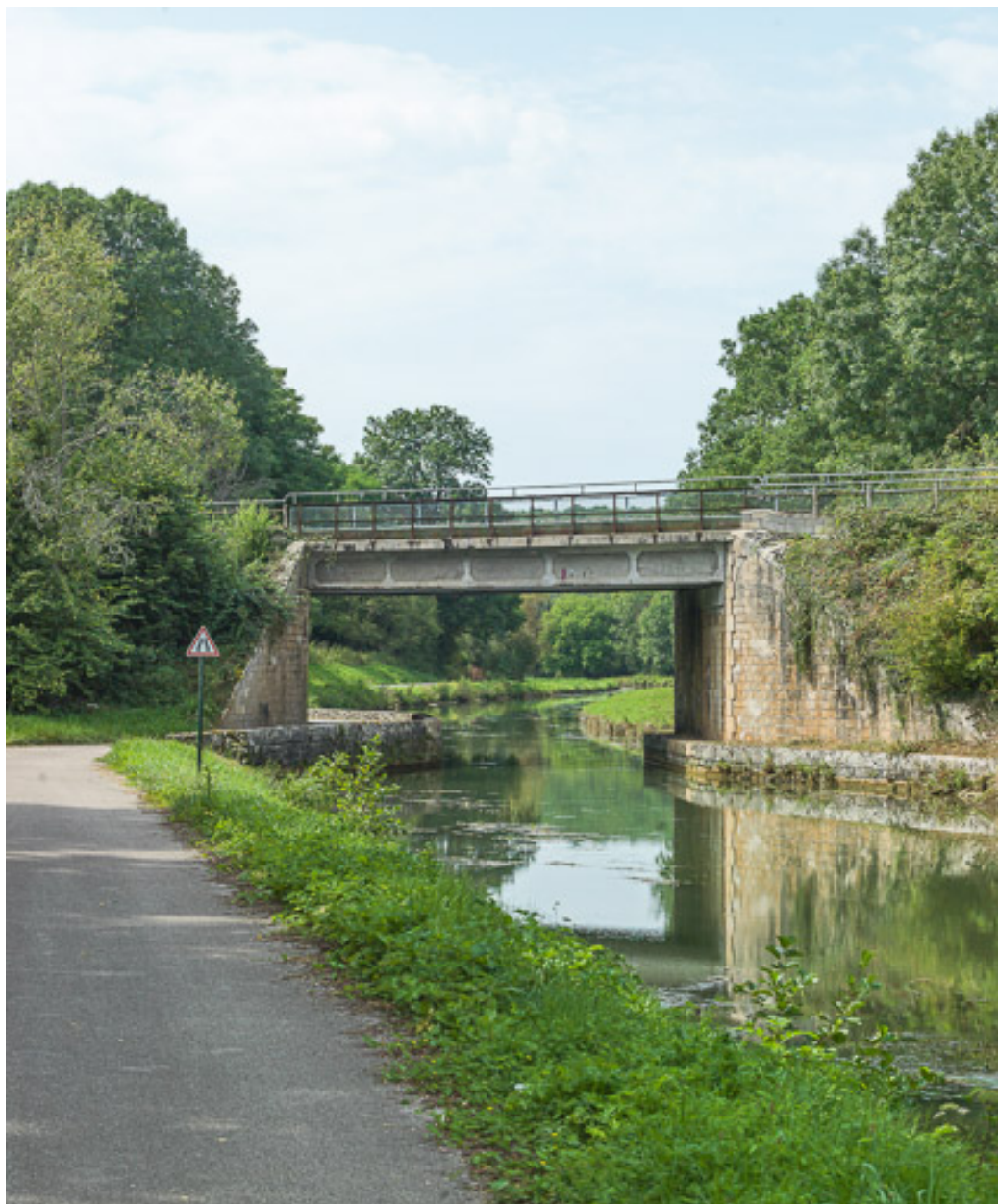
Vue d'ensemble du pont.
