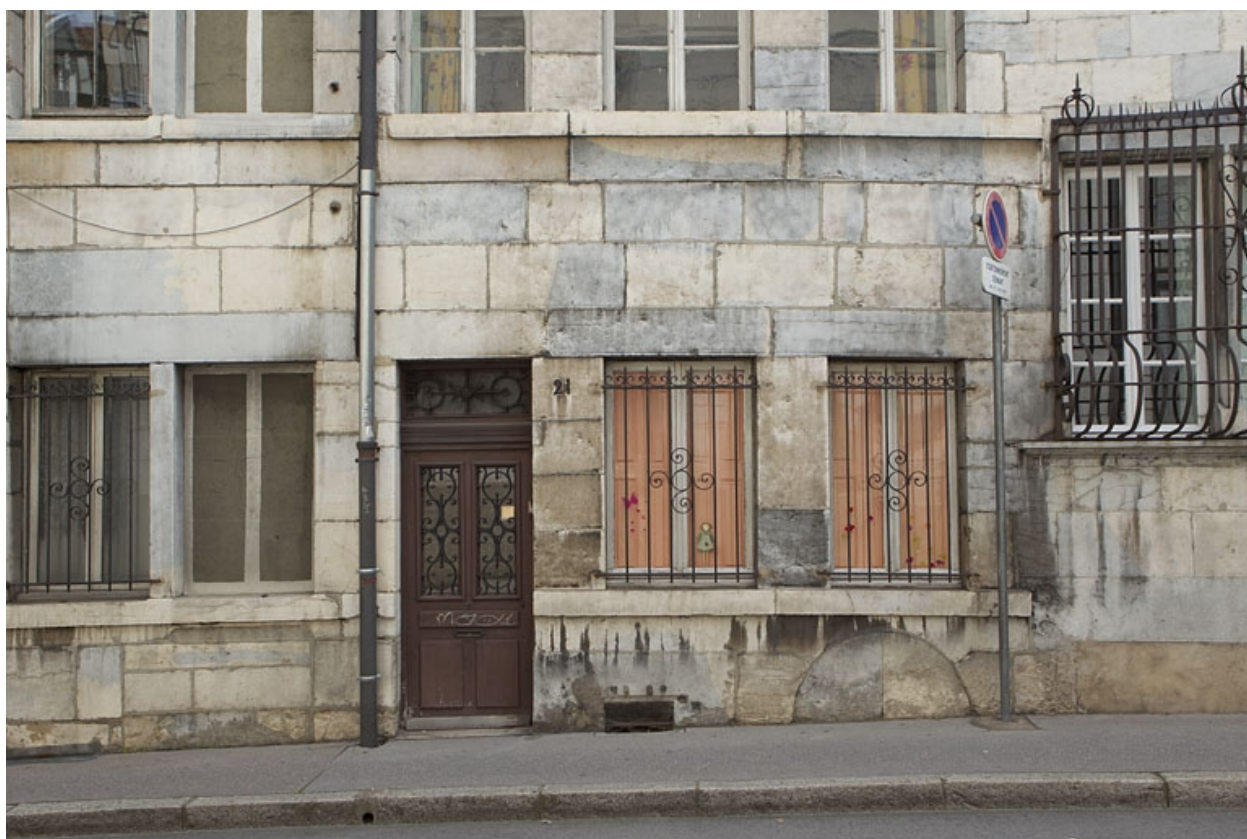
Façade antérieure du logis : détail du rez-de-chaussée.
