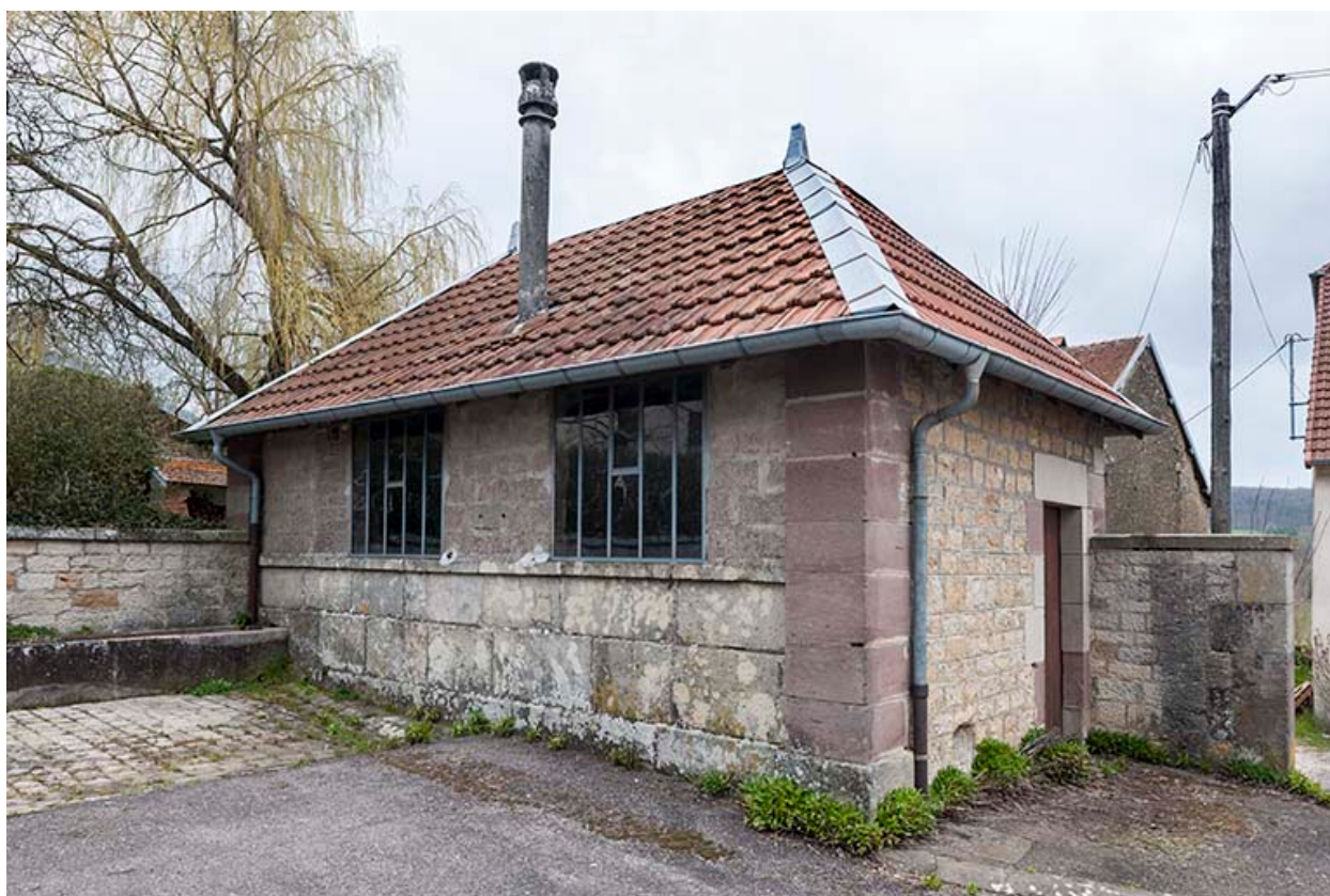
Le lavoir, transformé en local municipal.
