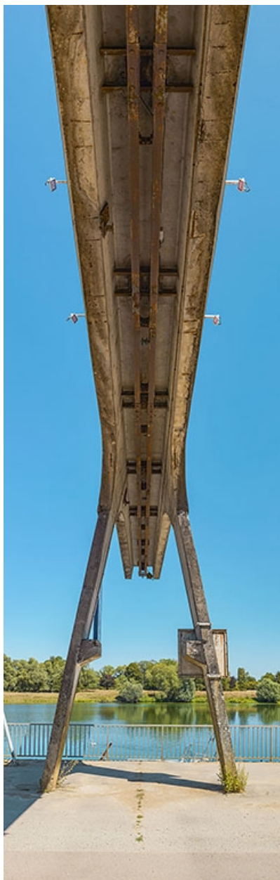
Portique de déchargement avec poulie.
