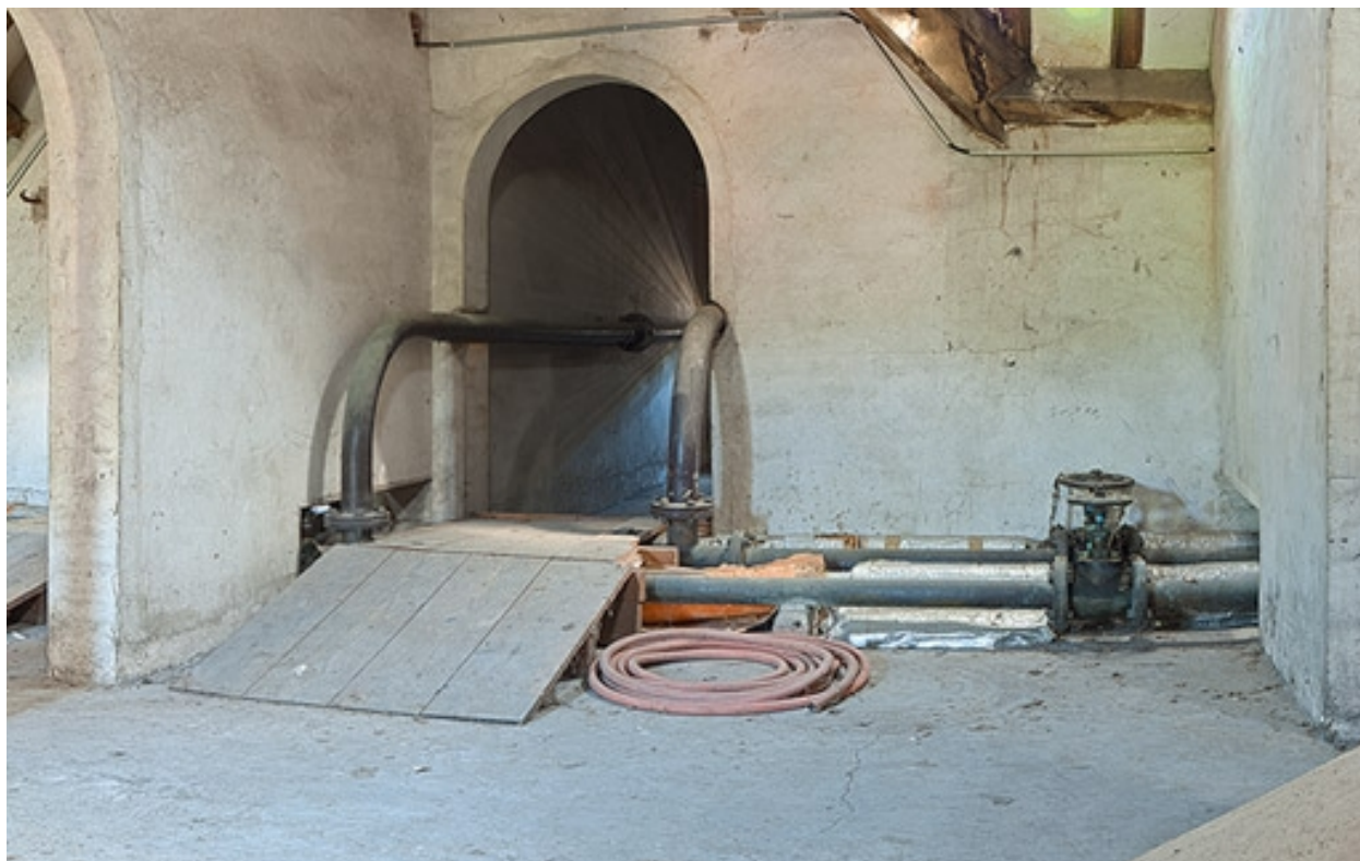
Comble : porte menant à l'aqueduc.
