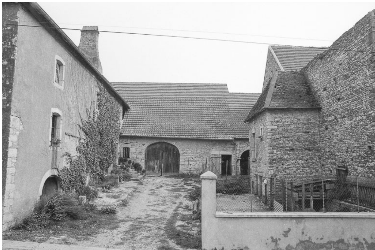
Façades sur cour.
