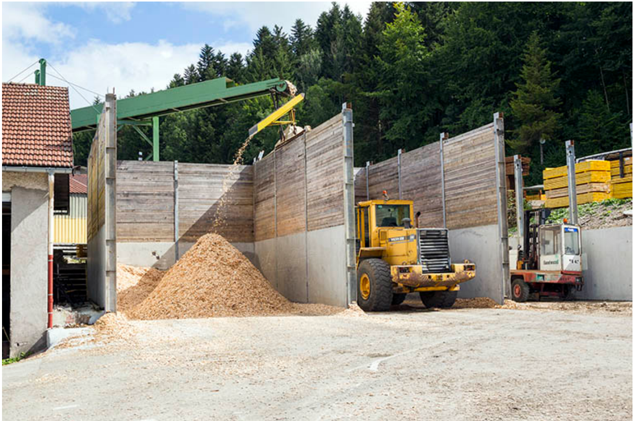
Silos à copeaux (B).
