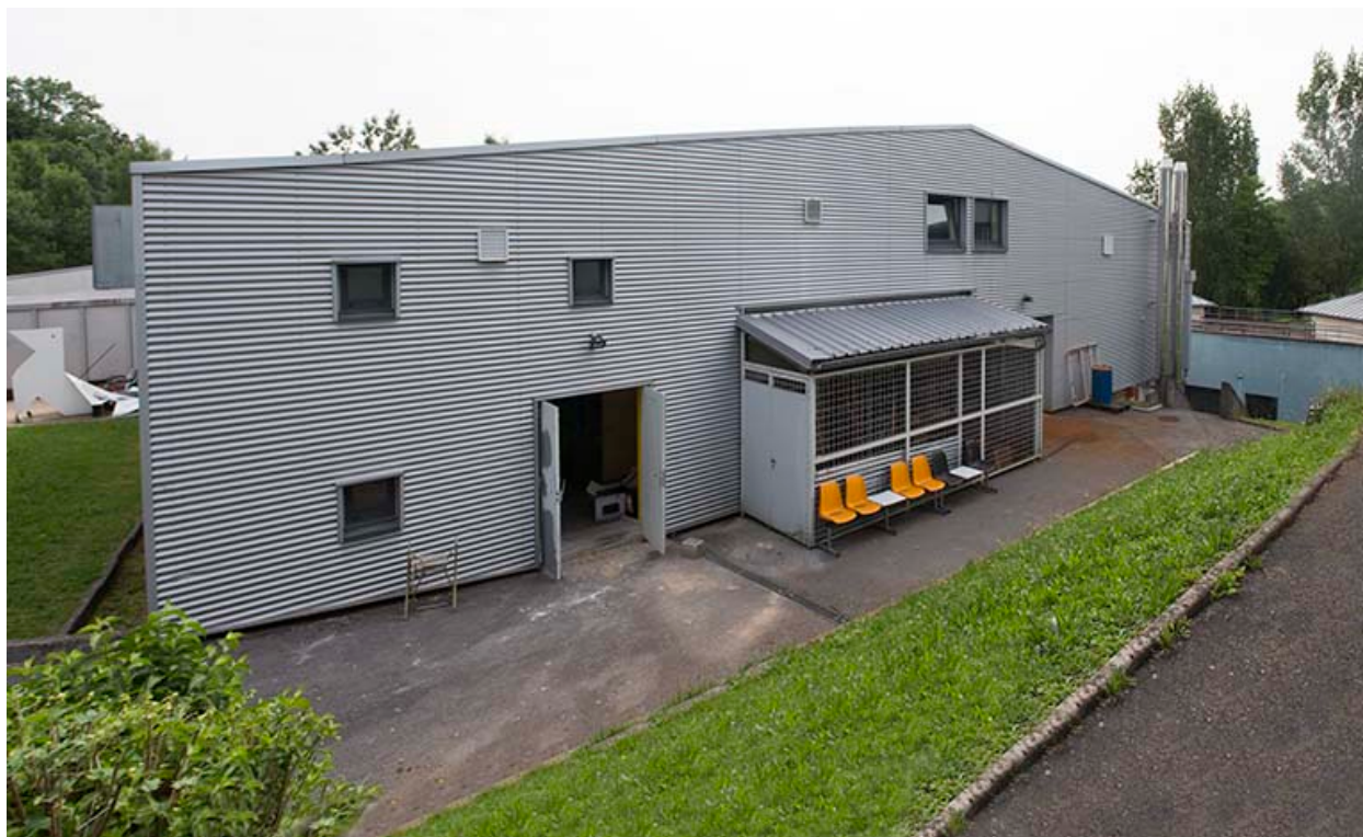
Façade sud-ouest des ateliers.
