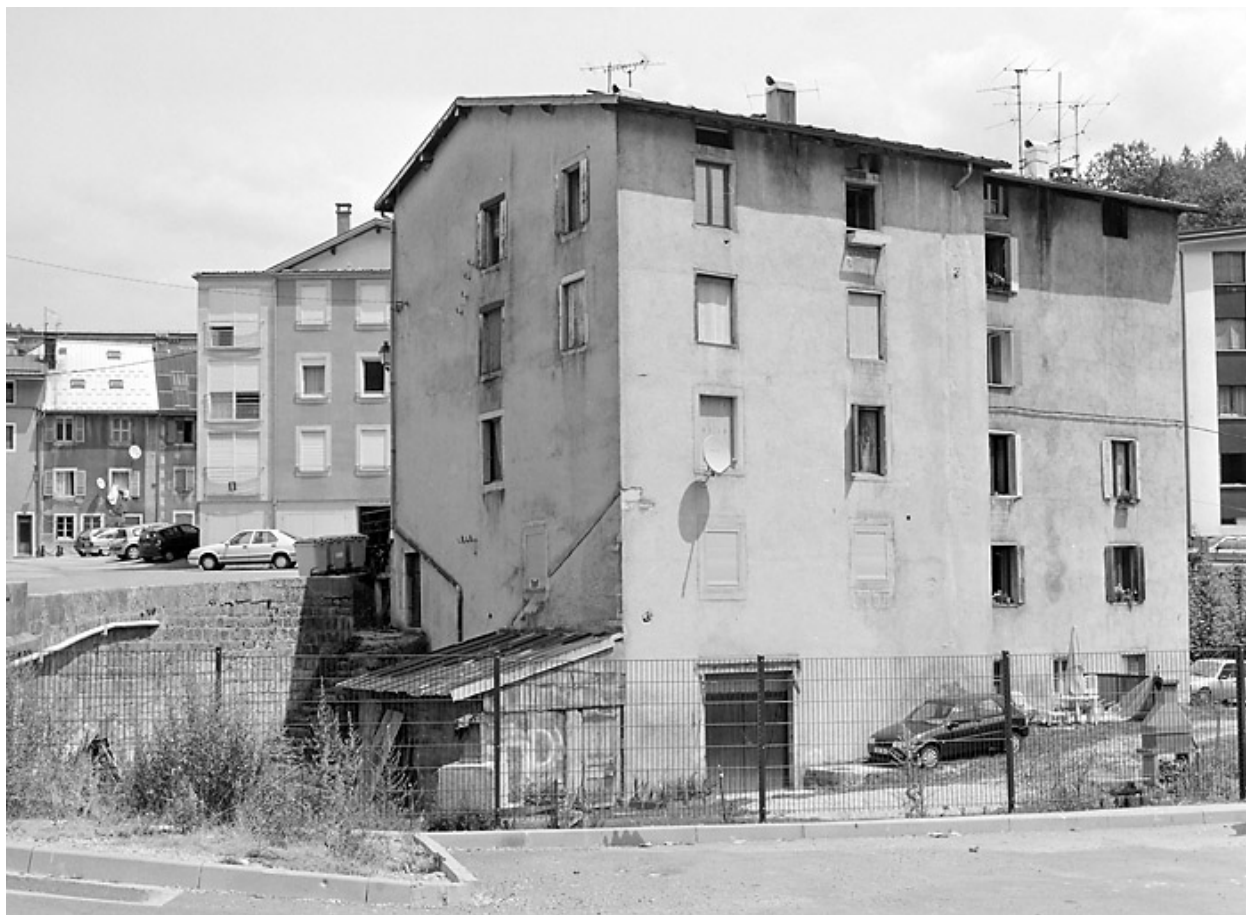
Elévation postérieure, de trois quarts gauche.
