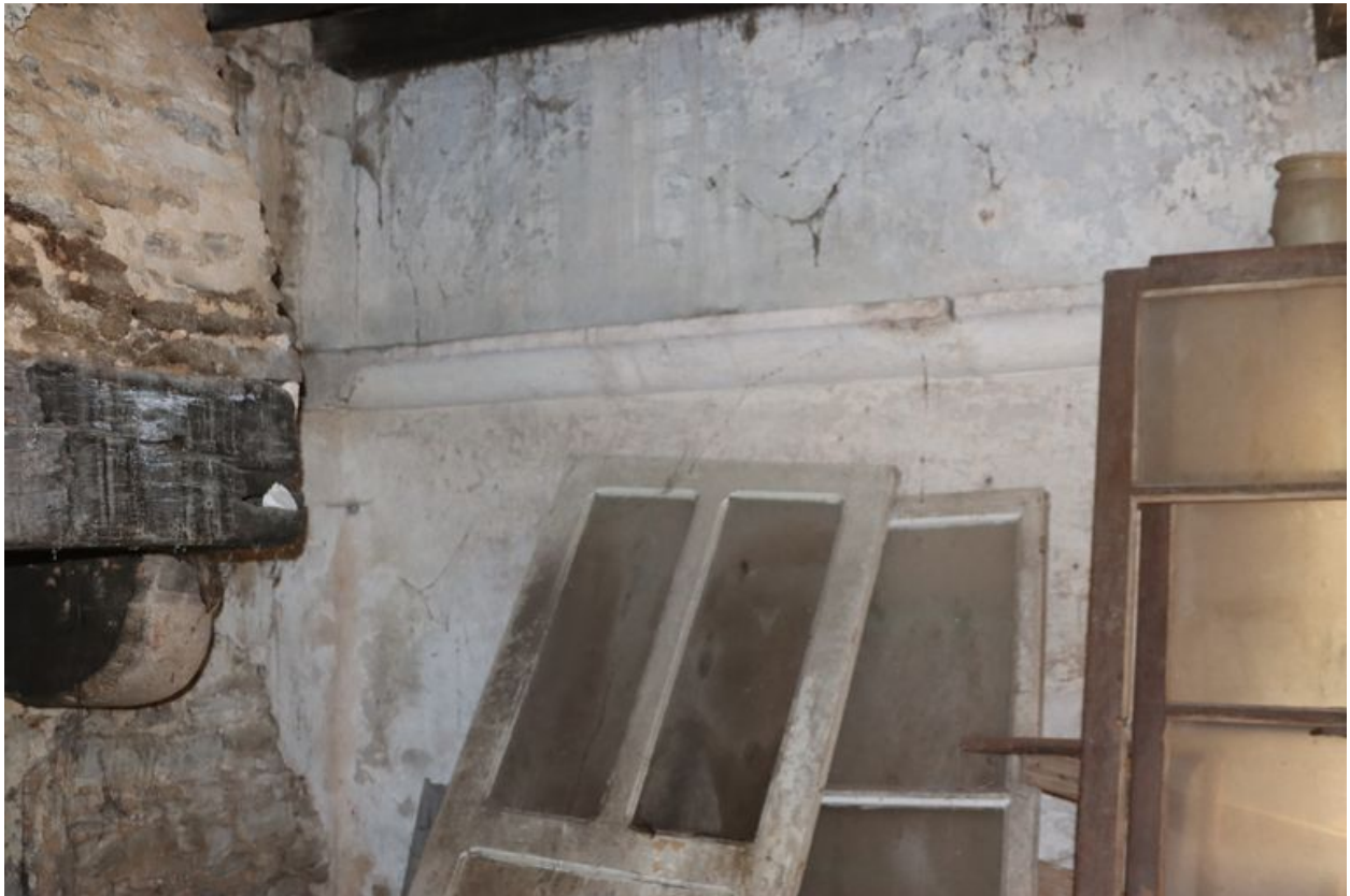
Détail d'un bandeau courant sur le mur sud de l'extension.
