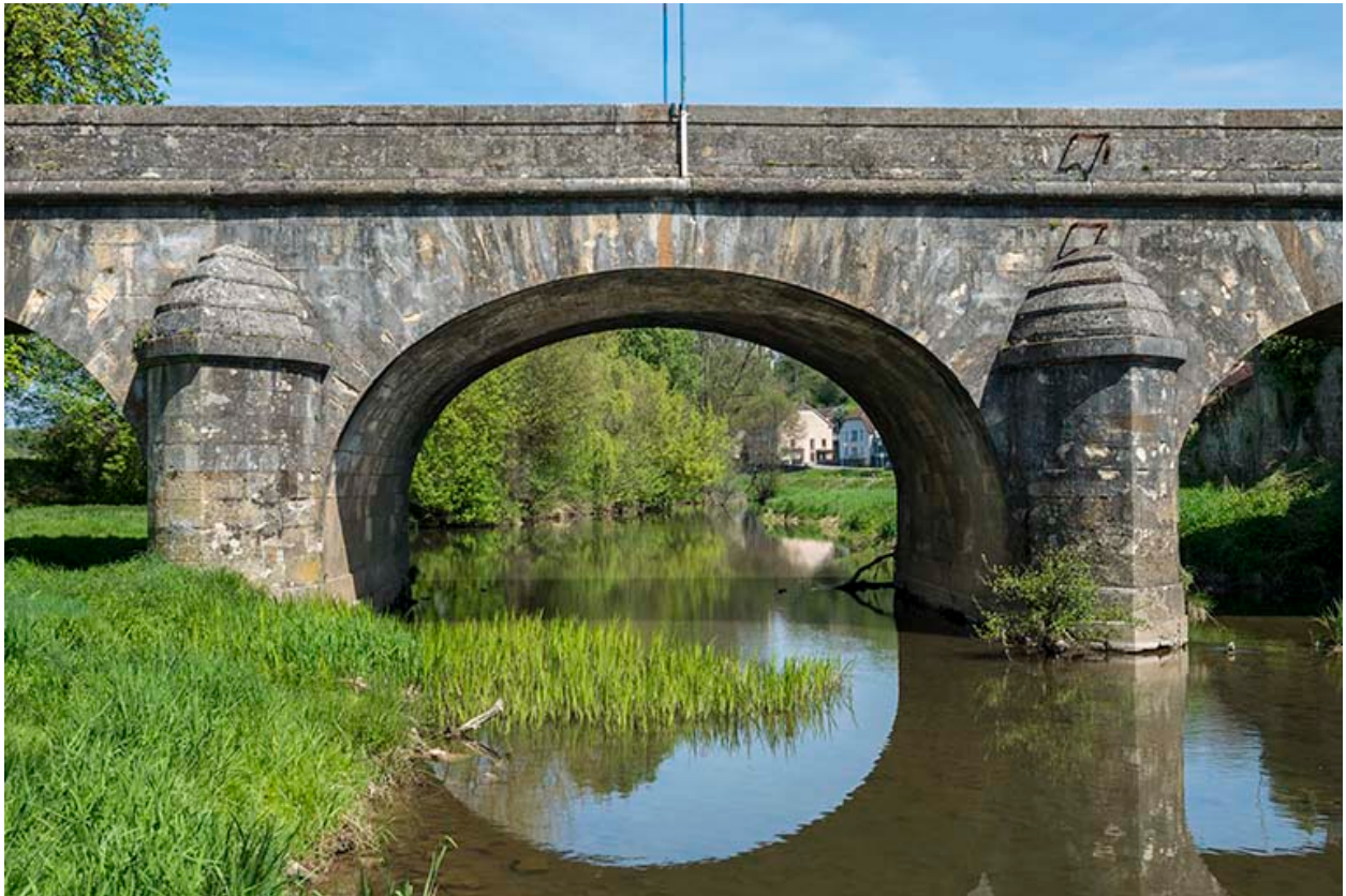
Détail de l'arche centrale.
