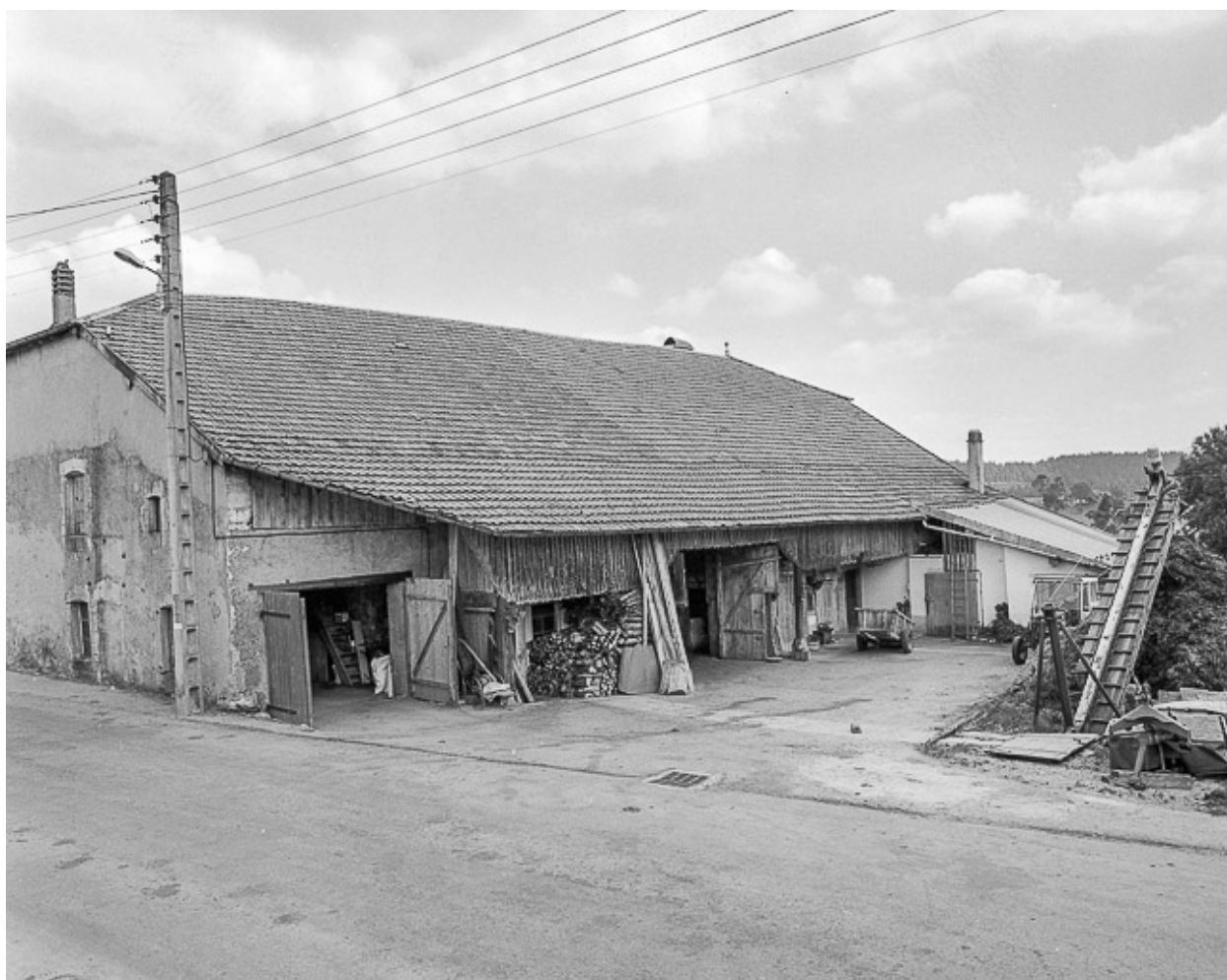
Mur goutterot d'une ferme.
