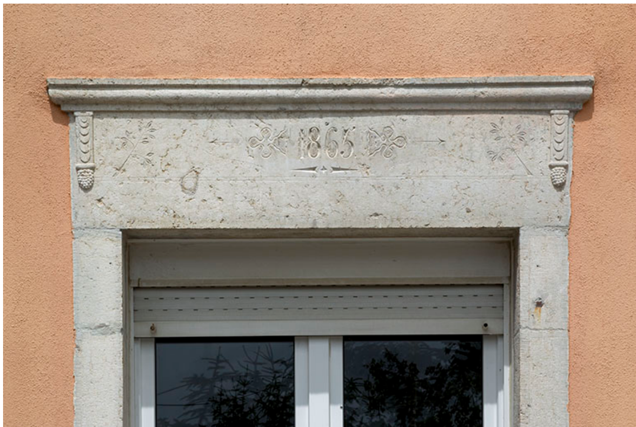
Façade postérieure : ancienne porte avec linteau daté.
