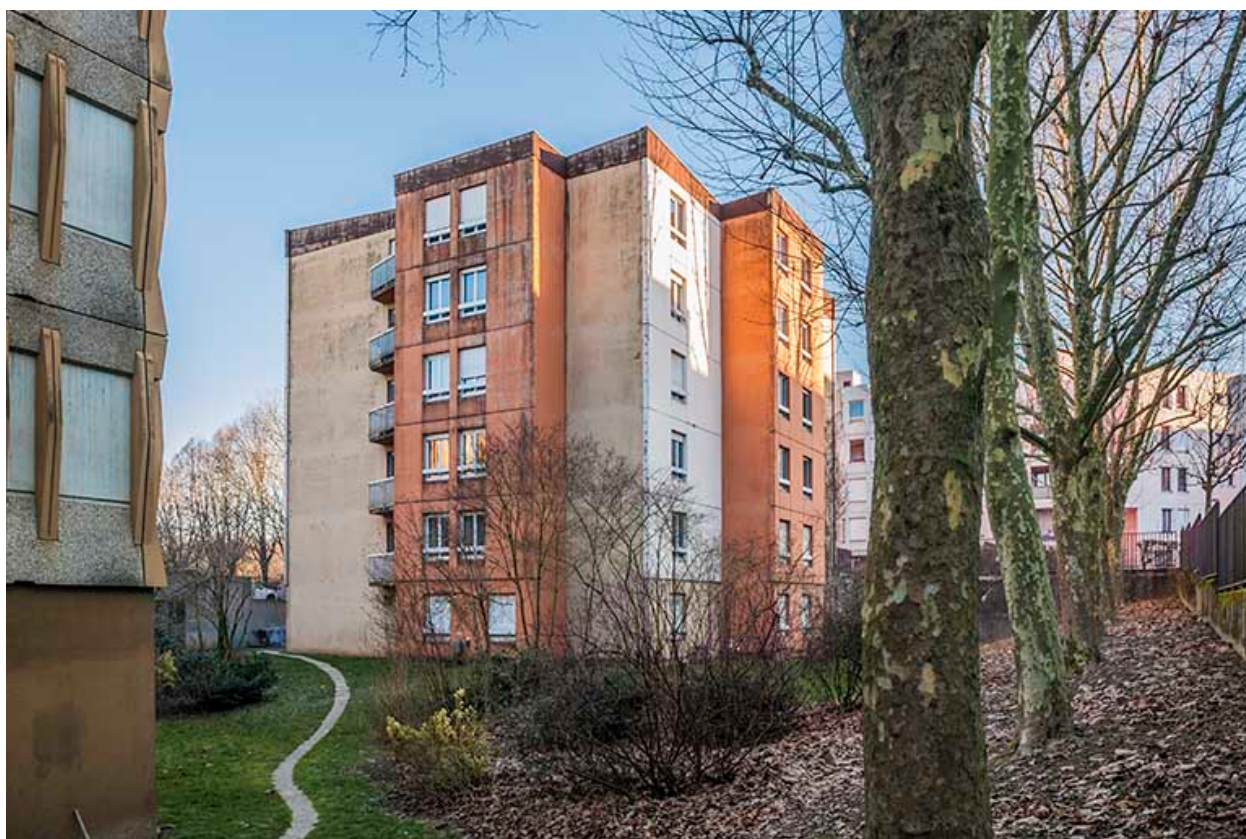
Angle sud des logements.
