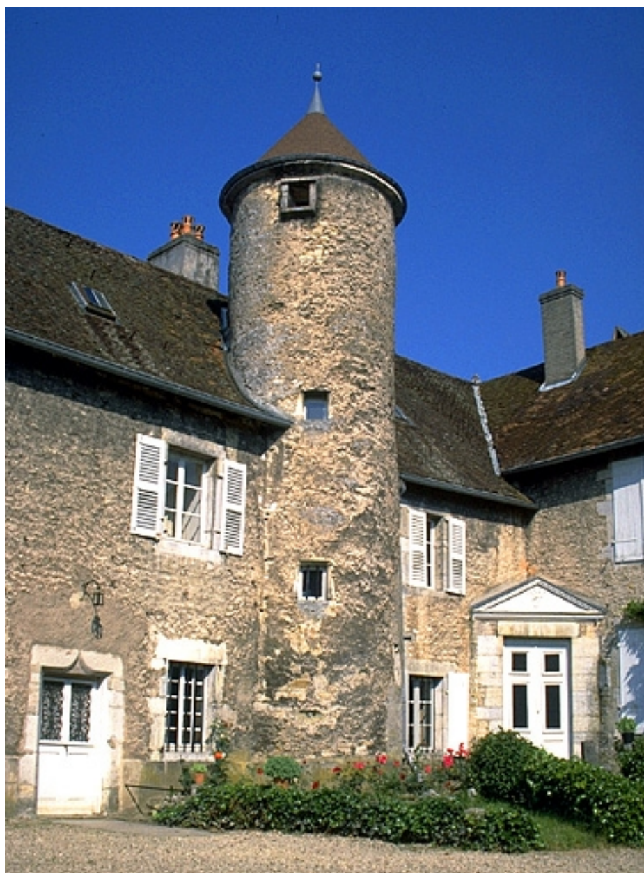
Façade antérieure du logement patronal.
