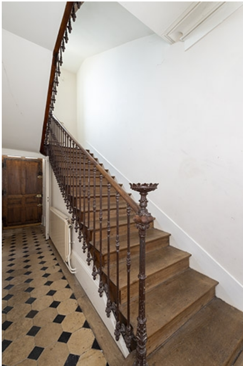
Escalier rampe-sur-rampe avec repos formant retour complet à gauche, vue depuis le palier du rez-de-chaussée.
