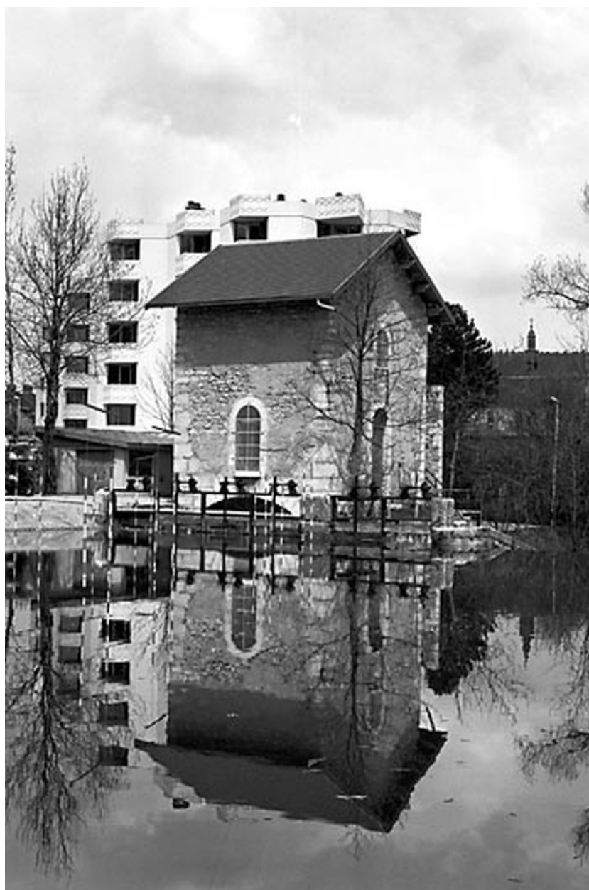
Bâtiment d'eau (local de la turbine) en 1980.
