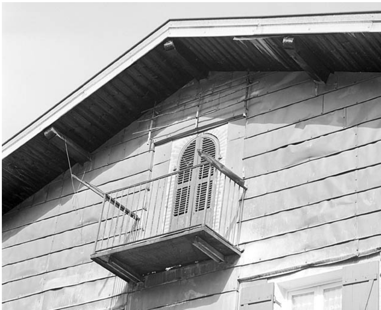
Façade latérale droite : porte haute et balcon.
