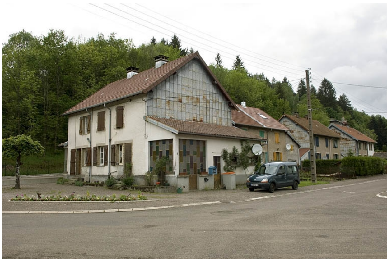
Logements ouvriers (rue des Cités).
