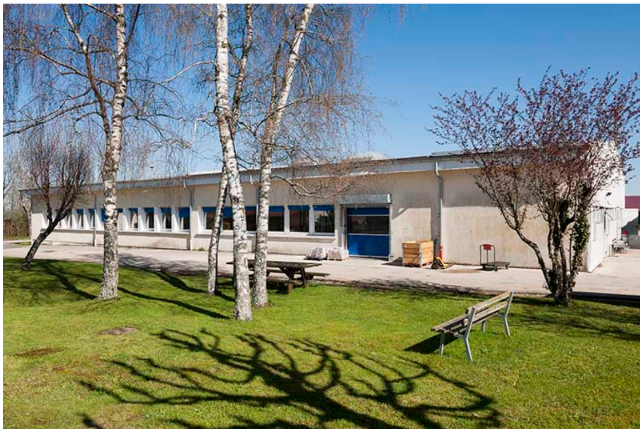
Vue depuis le sud-est.
