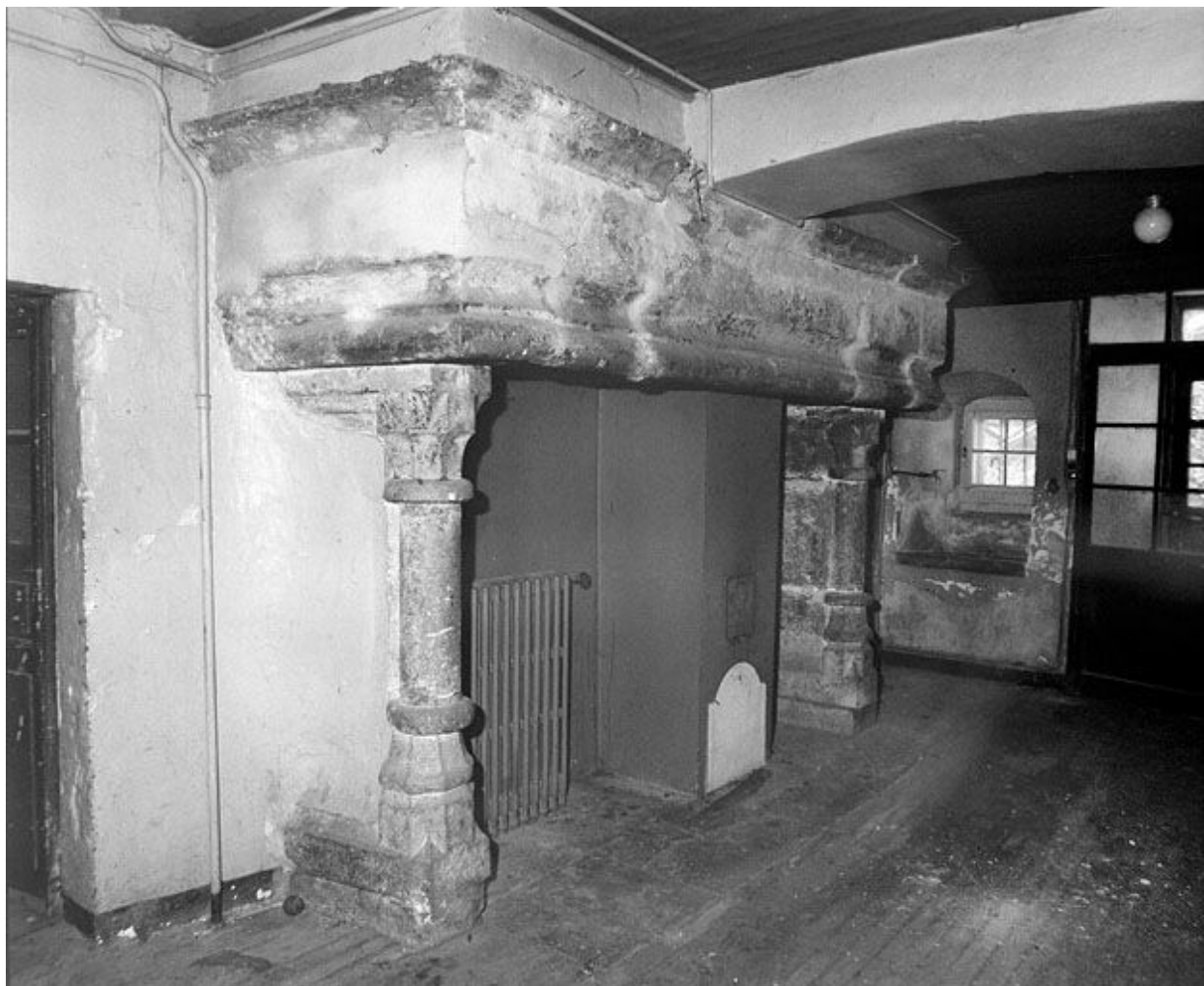
Vue intérieure, cheminée.
