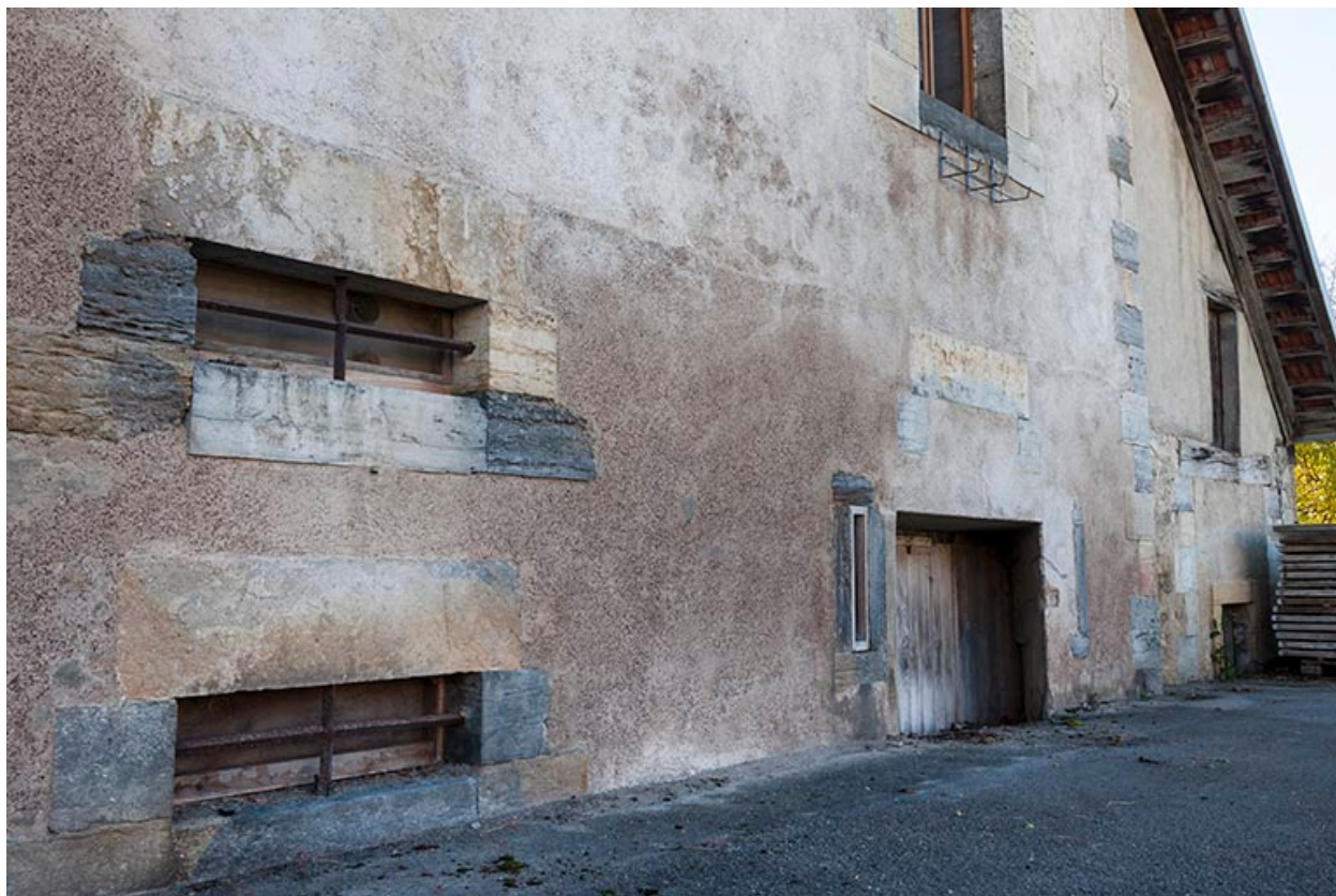
Ouvertures (caves d'affinage) sur la façade postérieure.
