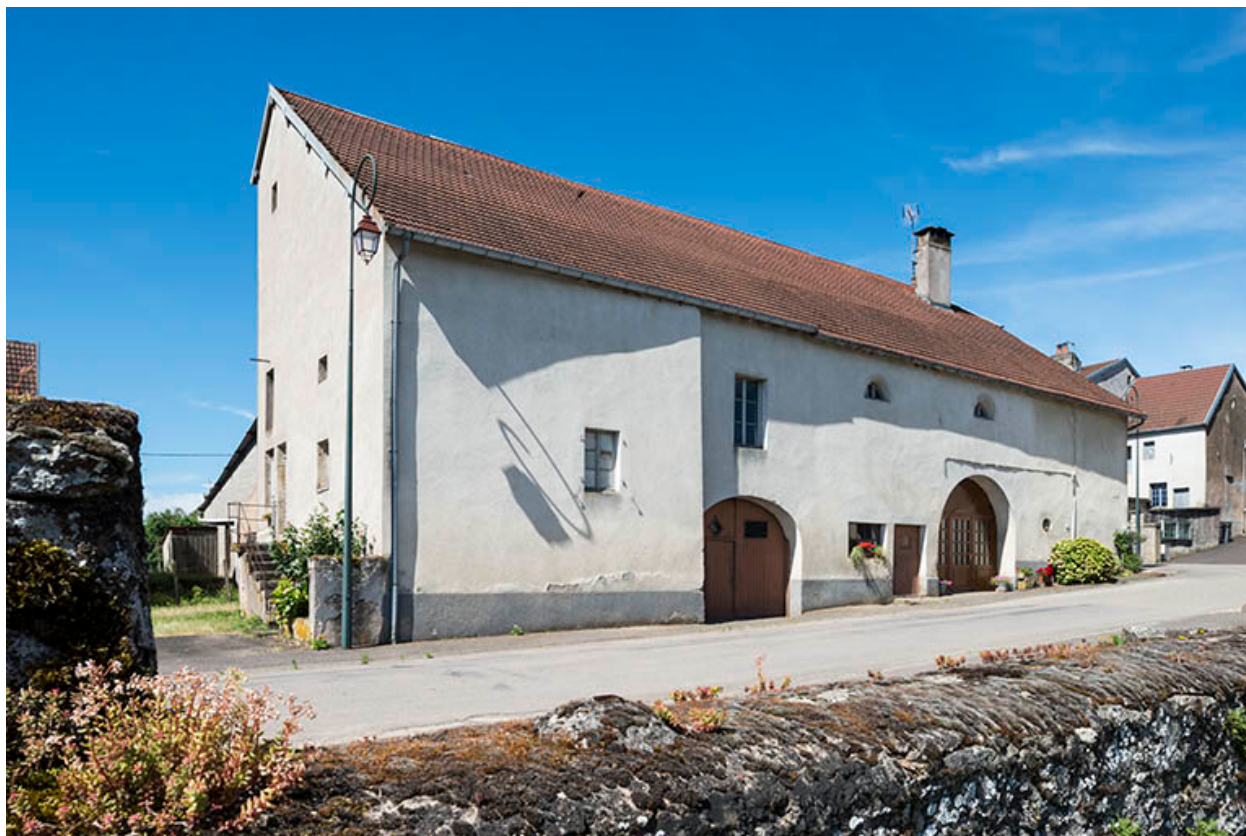
Ferme située au n°2 route de Scey-sur-Saône.
