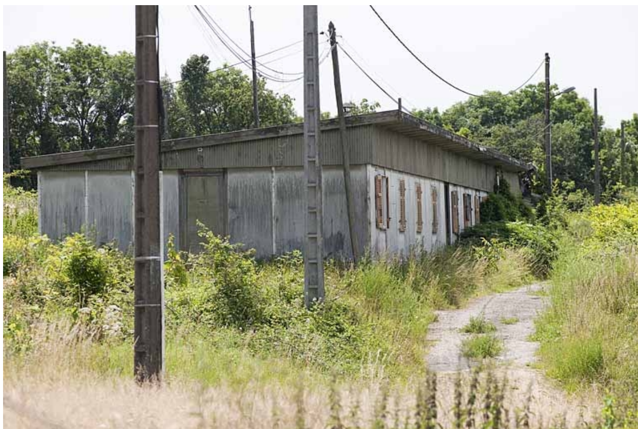
Logement P (en ruines).
