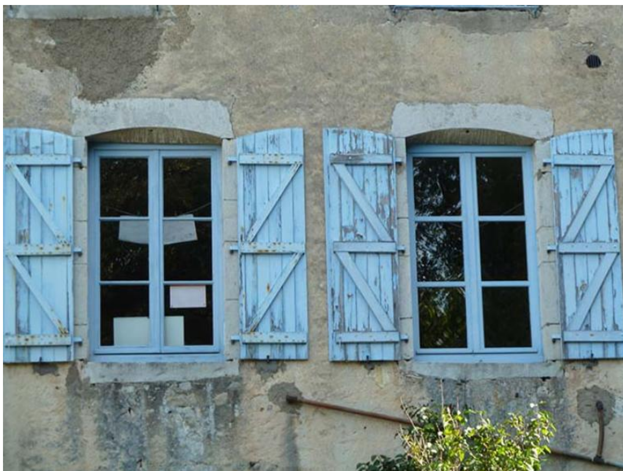
Détail des baies de la façade ouest
