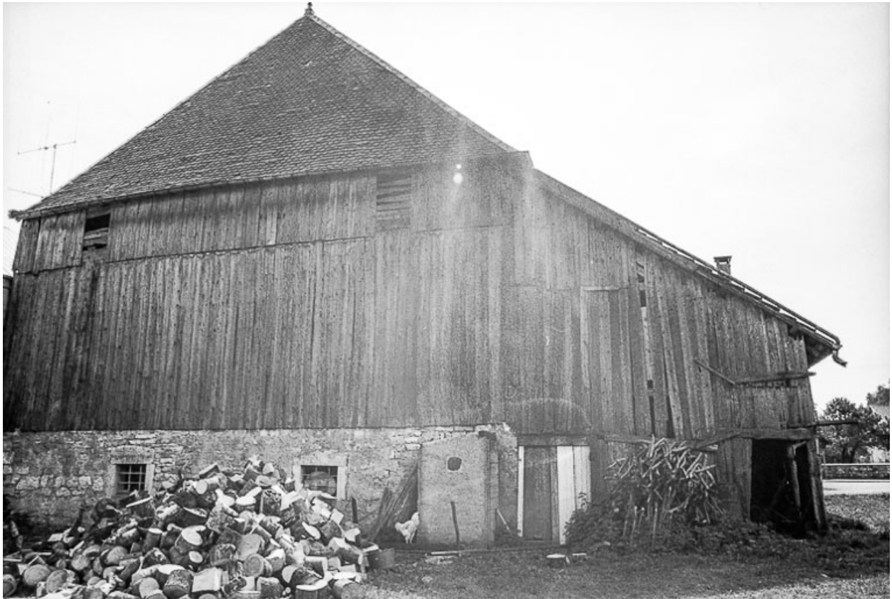
Ferme cadastrée 1962 E 80 : façade latérale (?).
