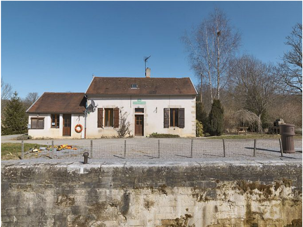
La maison éclusière de face.
