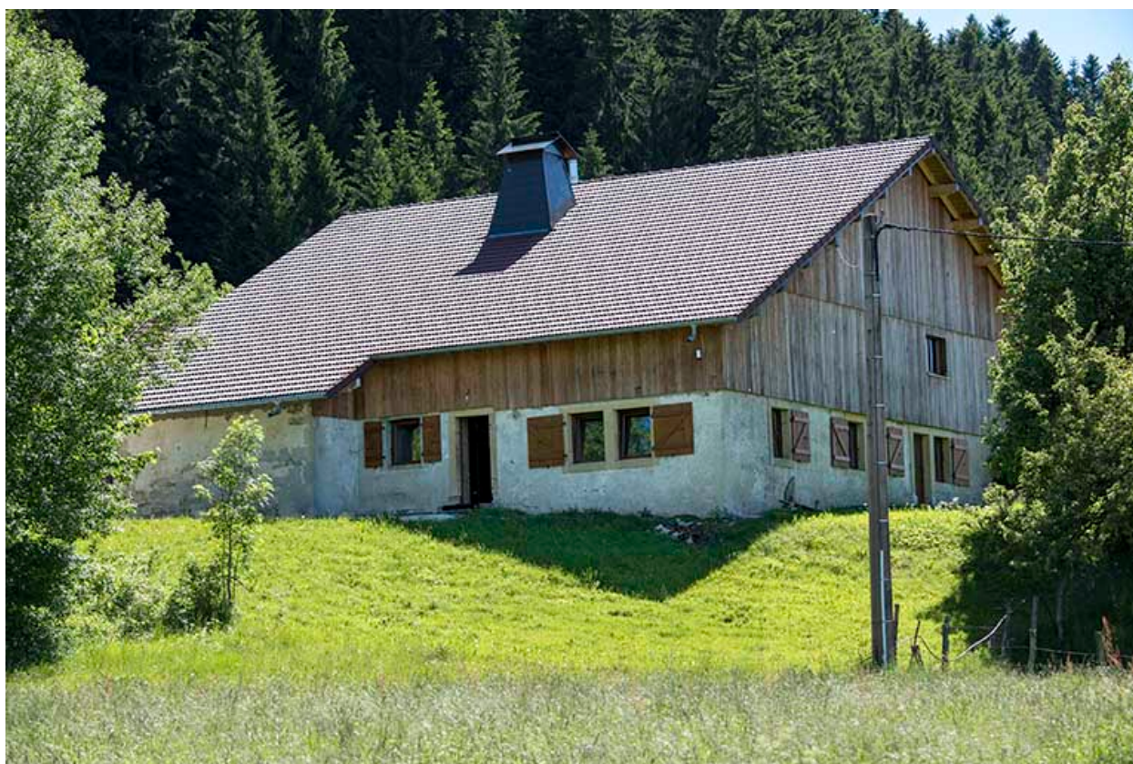
Façades postérieure et latérale droite.
